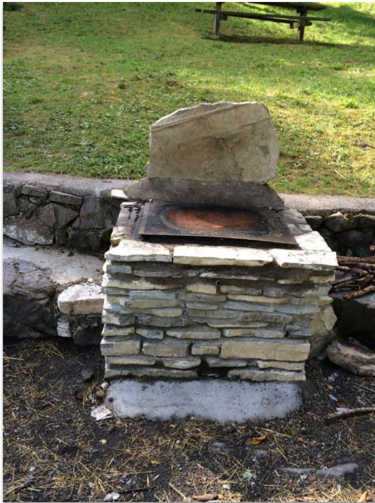
Réparation de la place à feu de la base de loisirs.
